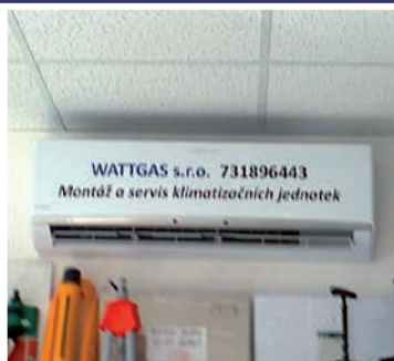
Klimatizační a topné jednotky
