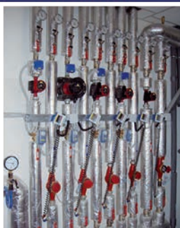
Tepelná čerpadla včetně vyřízení dotace
