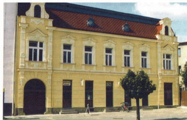
Obr. 2 Objekt po sanaci vlhkého zdiva
