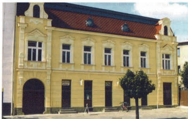
Obr. 2 Objekt po sanací vlhkého zdiva
