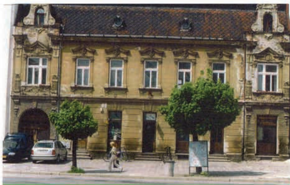
Obr. 1 Objekt před sanací vlhkého zdiva
