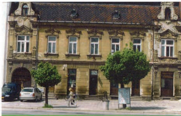
Obr. 1 Objekt před sanací vlhkého zdiva
