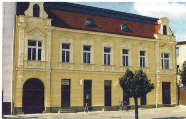
Obr. 2 Objekt po sanaci vlhkého zdiva
