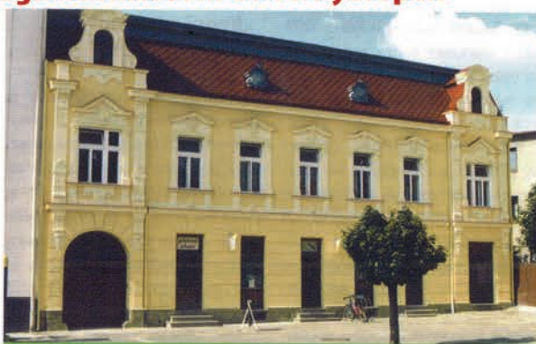
Obr. 2 Objekt po sanaci vlhkého zdiva
