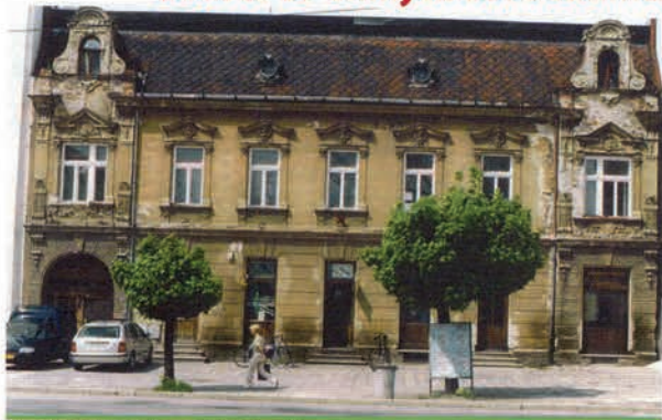
Obr. 1 Objekt před sanací vlhkého zdiva
