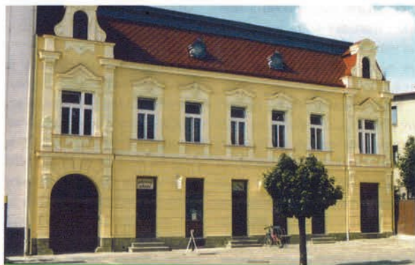
Obr. 2 Objekt po sanaci vlhkého zdiva
