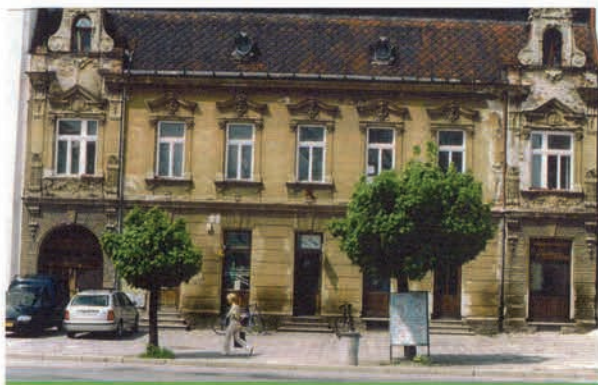
Obr. 1 Objekt před sanací vlhkého zdiva
