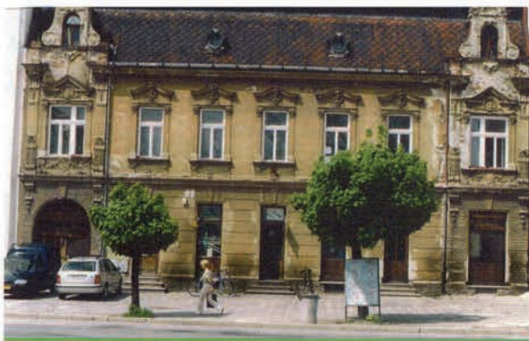
Obr. 1 Objekt před sanací vlhkého zdiva
