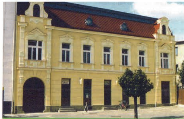
Obr. 2 Objekt po sanaci vlhkého zdiva
