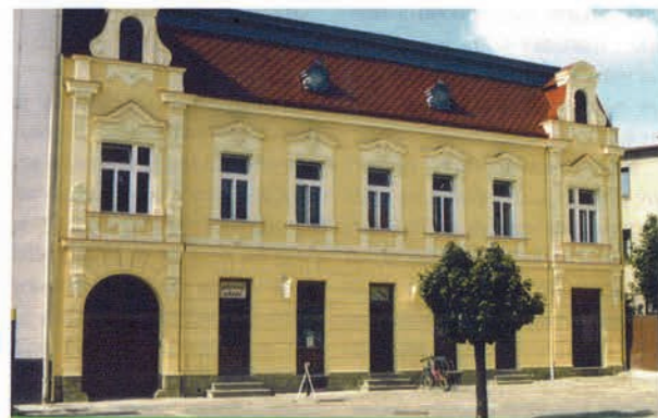
Obr. 2 Objekt po sanaci vlhkého zdiva
