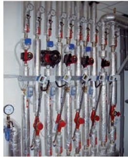
Tepelná čerpadla včetně vyřízení dotace
