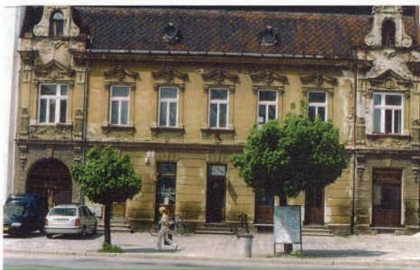
Obr. 1 Objekt před sanací vlhkého zdiva
