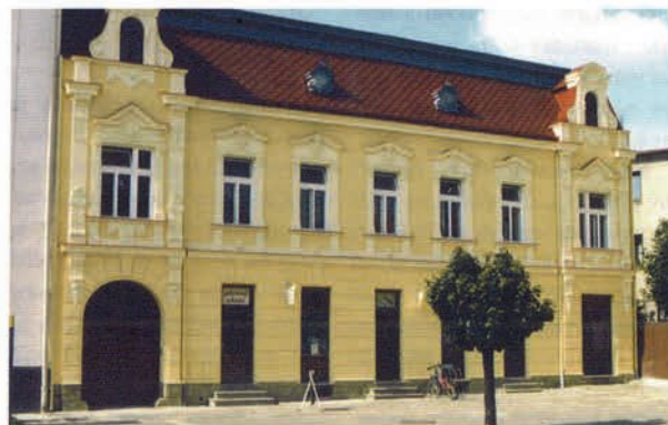
Obr. 2 Objekt po sanaci vlhkého zdiva
