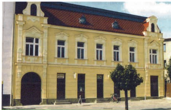
Obr. 2 Objekt po sanaci vlhkého zdiva
