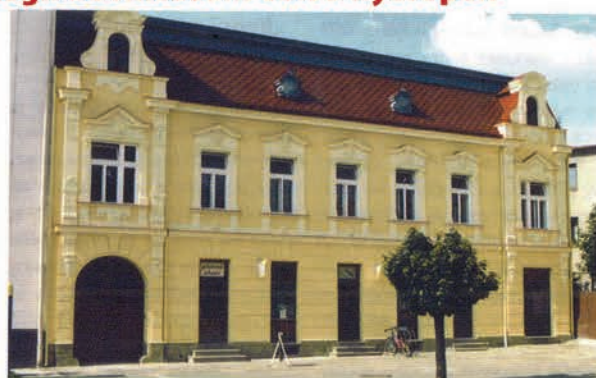
Obr. 2 Objekt po sanaci vlhkého zdiva
