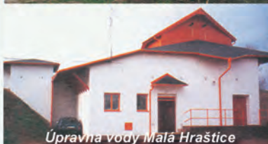
Úpravna vody Malá Hraštice
