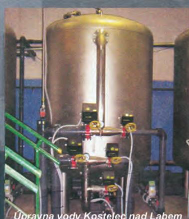
Úpravna vody Kostelec nad Labem
