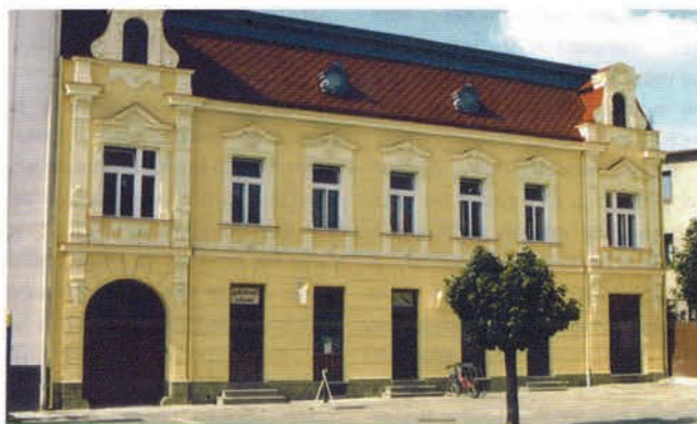
Obr. 2 Objekt po sanací vlhkého zdiva
