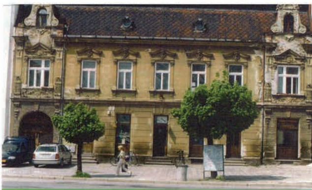
Obr. 1 Objekt před sanací vlhkého zdiva
