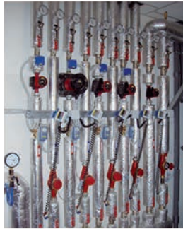
Tepelná čerpadla včetně vyřízení dotace
