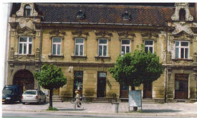
Obr. 1 Objekt před sanací vlhkého zdiva
