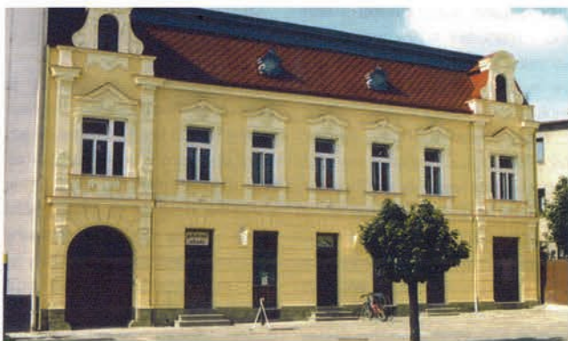
Obr. 2 Objekt po sanací vlhkého zdiva
