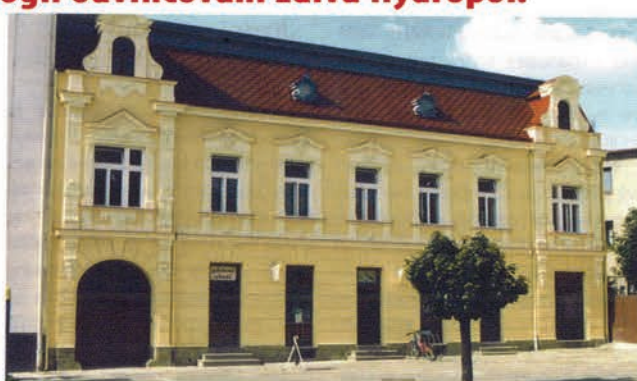
Obr. 2 Objekt po sanaci vlhkého zdiva
