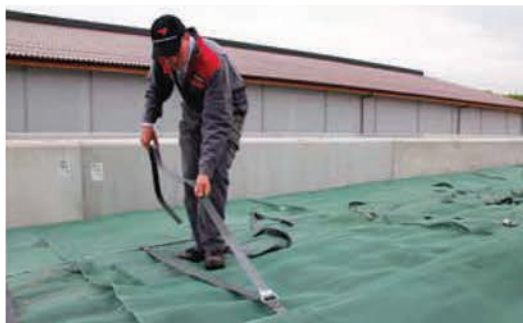
Krok 4: Tkané pásy jsou staženy z obou stran pomocí pásů se západkami. Stahování se provádí pomocí železných pák.
