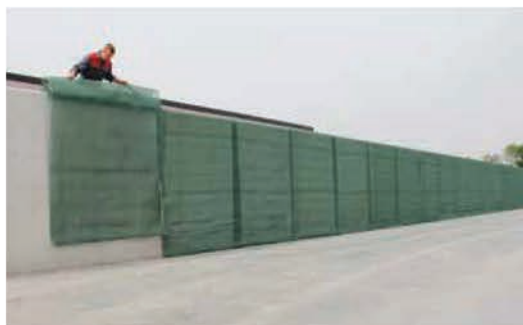
Krok 1: Tkané pásy jsou instalovány na stěnu žlabů s 25 cm překrytím po obou stranách silážního žlabu.
