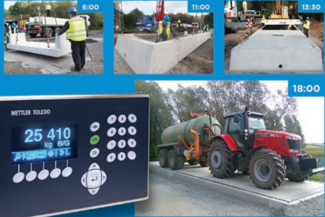
Postup výstavby silniční váhy
